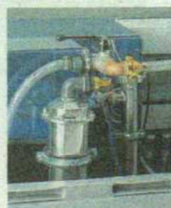
Den Kern der Aufbereitungsanlage bilden neben den Filtern eine UV-Lampe (li. im Bild). Sie sorgt dafür, dass das Waisenhaus (rechtes Bild) künftig mit sauberem Wasser versorgt werden kann. (Fotos: Spectrum/Privat)
